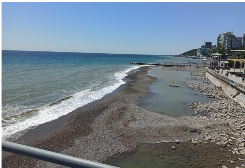
Рисунок 6.3 — Устье и морская приустьевая зона акватории города Ялта во время паводка на реке Водопадная [22]
